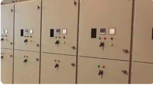
Las Celdas de Media Tensión cuentan con un sistema de juego de barras simples, además, incluyen una barra de tierra, horizontal a través de todo su largo. Estas barras están diseñadas para aceptar conexiones futuras en ambos extremos.
