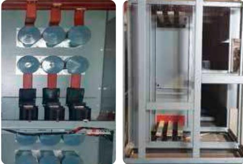
Cuentan con un enclavamiento mecánico para evitar cerrar el seccionador de puesta a tierra, si el interruptor correspondiente está en la posición de servicio. Los seccionadores de puesta a tierra deberán estar conectados sólidamente a todas las borneras ubicadas en las celdas deberán tener acceso para la verificación del cableado y posterior conexionado de los circuitos externos en obra.
