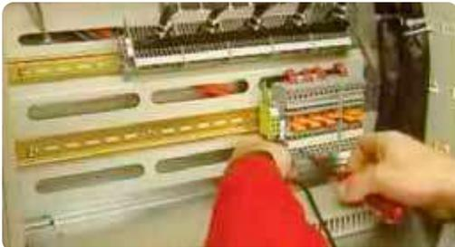
El cable de control utilizado para el alambrado del gabinete es cobre flexible de temperatura de operación clase 90°C. el aislamiento del conductor es libre de halógenos, resistente a la llama y la humedad.
