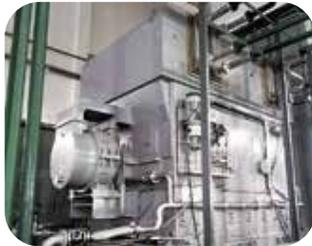
Inversor y motor de 8 MW utilizados para accionar un compresor en la plataforma petrolera de CNOOC.
