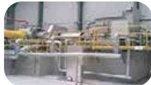
El primer conjunto de convertidor de frecuencia fabricado localmente, que acciona un compresor de oleoducto para el oleoducto Jining de PetroChina.
