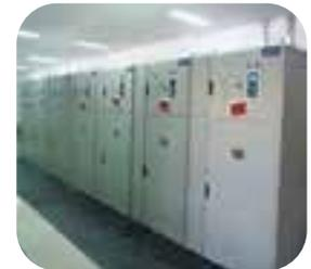
3 arrancadores suaves de 2700 kW, 1 kV, utilizados para accionar u compresor bifásico HAFA en Irak.
