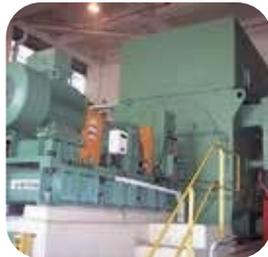
Motor de 11,500 kW, 11 kV, utilizado para accionar el agitador en el proyecto Kobelco, Japón-Borouge.
