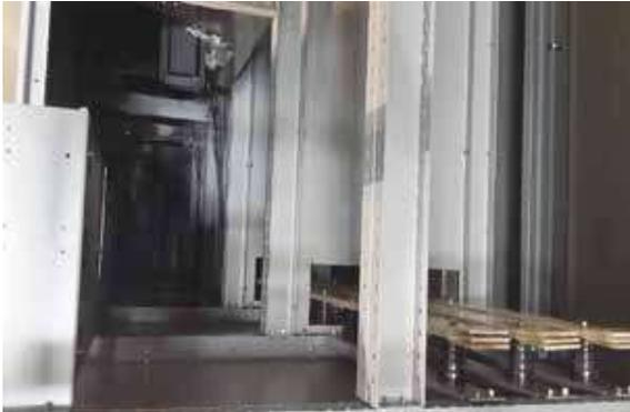
El alambrado se soporta mediante canal-e-tas con tapas desmontables para prevenir que presente caídas. La aislación del cable de control es de tensión nominal 0,6/1 kV, según IEC 60502.
