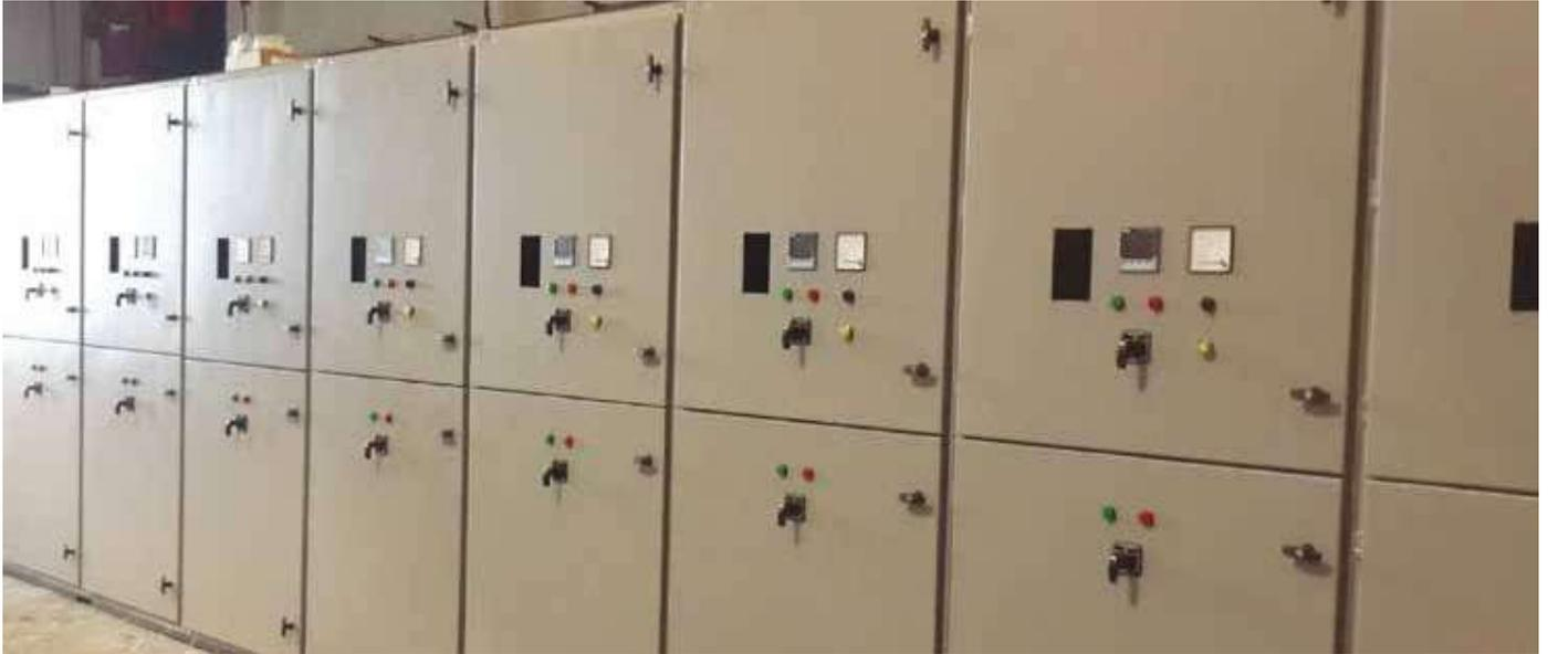
Las Celdas de Media Tensión cuentan con un sistema de juego de barras simples, además, incluyen una barra de tierra, horizontal a través de todo su largo. Estas barras están diseñadas para aceptar conexiones futuras en ambos extremos.
